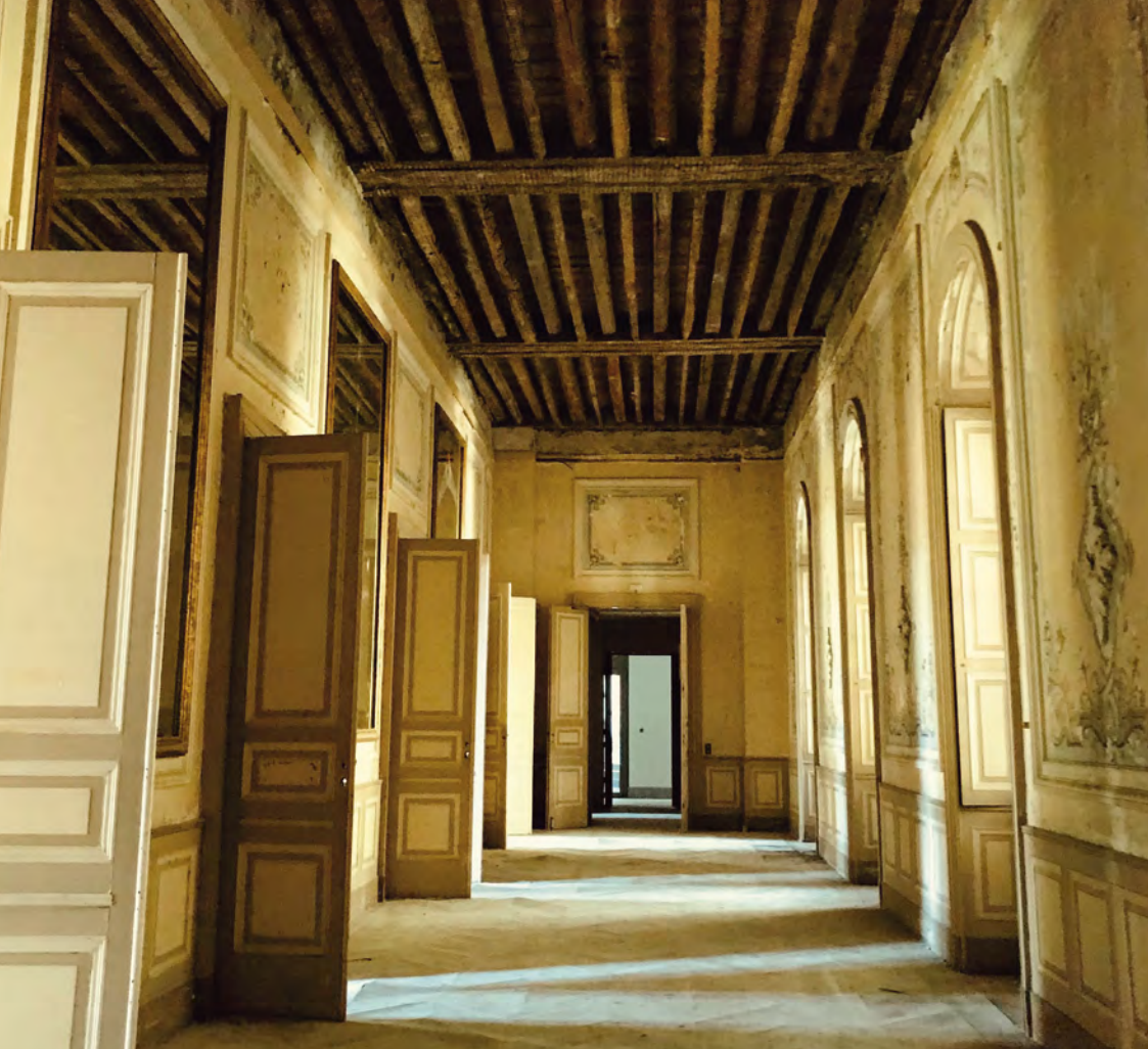
• Galerie d'honneur de l'Hôtel de ville suite au curage du bâtiment en 2021.
